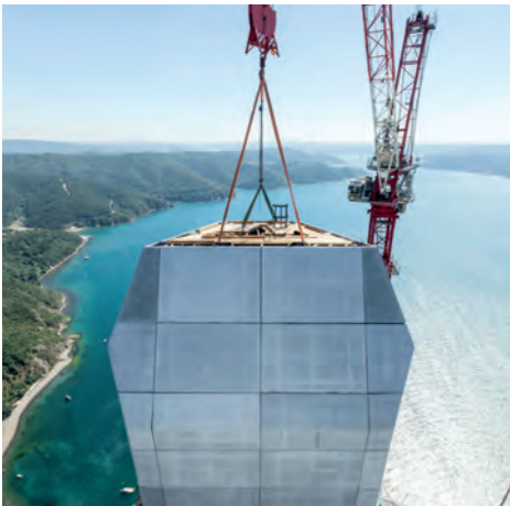
Abb. 6a, b: Platten mit Glas- und Carbonbewehrung an der Bosphorus-Brücke in Istanbul (Fotos: Solidian GmbH)
