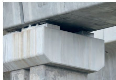
Die Einfeldträger liegen auf je 4 Lagern
