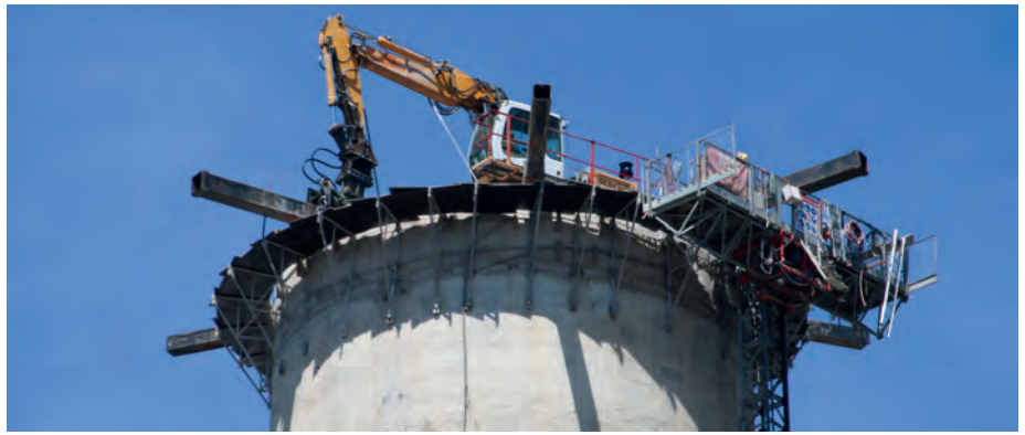
Abb. 3: Ab 85 bis 20 m Höhe kam der Spinnenbagger zum Einsatz
