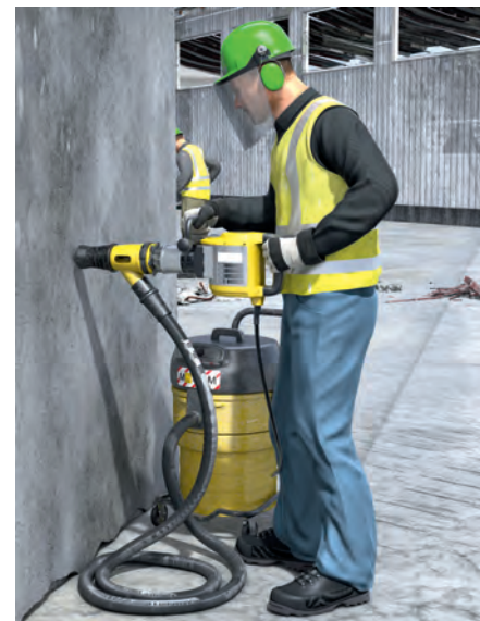
Abb. 2: Um Gefährdungen durch Staub und andere Gefahrstoffe zu vermeiden, sollten beim Abbruch Bohrhammer mit Absaugung eingesetzt werden (Grafik: H.ZWEI.5)
