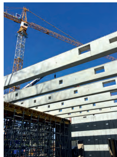
Abb. 5: Montage der Fertigteilbinder über dem 1. OG (Foto: Rico Mattusch)
