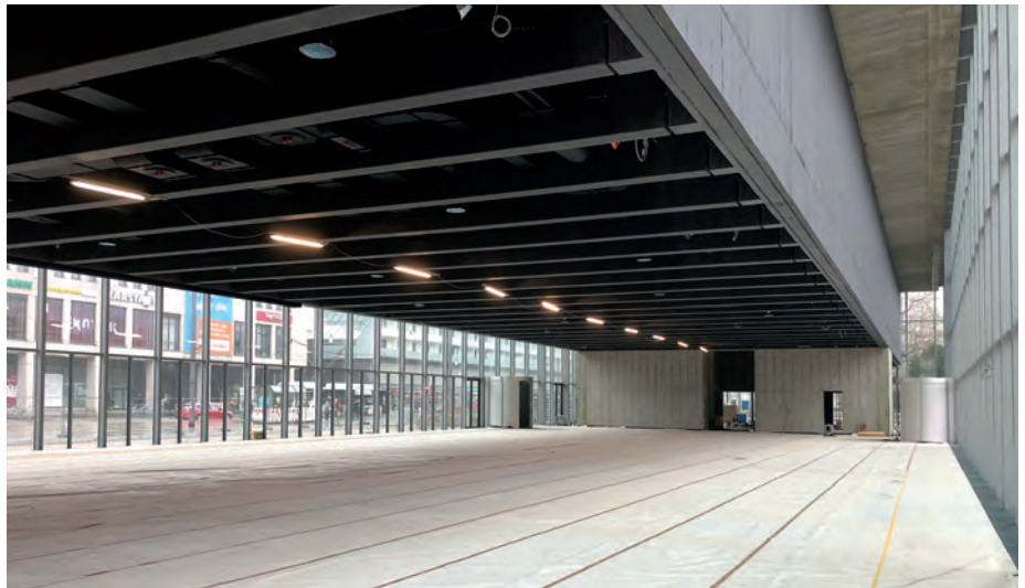
Abb. 8: Black Box mit Fassade – TGA-Führung ist gewollt sichtbar (Foto: Rico Mattusch)
