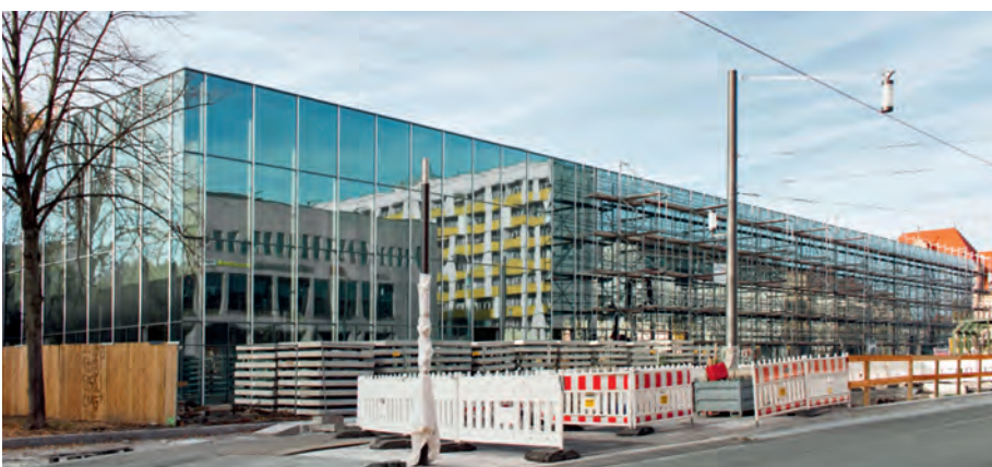
Abb. 11: Montage Glasfassade (Stiftung Bauhaus Dessau / Foto: Nathalie Wächter)
