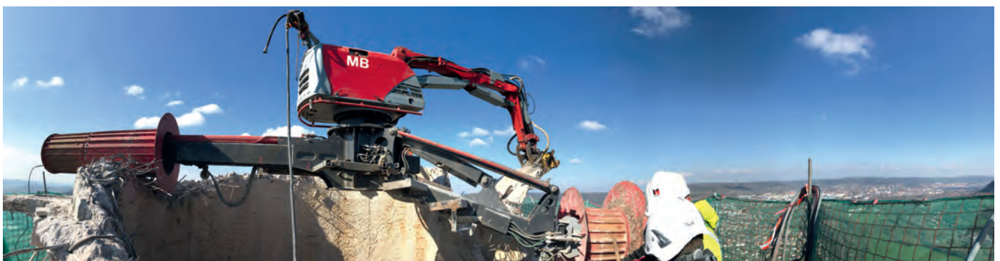
Abb. 2: Der Drivebreaker wird per Funkfernsteuerung bedient und ermöglichte den Rückbau des Schornsteins von 225 bis 85 m Höhe (Foto: Kai Mudra, Ostthüringer Zeitung)
