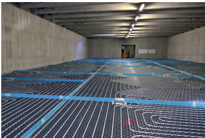
Abb. 9a: Verlegung Fußbodenheizung für Dauerausstellung (Foto: Inros Lackner)
