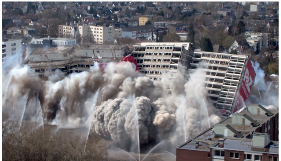
Abb. 6a und b: Einsatz von Hydroschilden zur Staubminimierung
