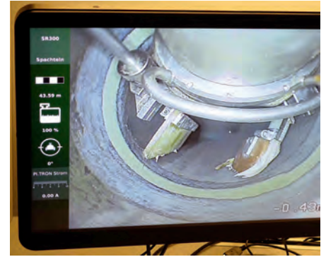
Über einen Monitor im Steuerfahrzeug werden die Reparaturarbeiten kontinuierlich überwacht
