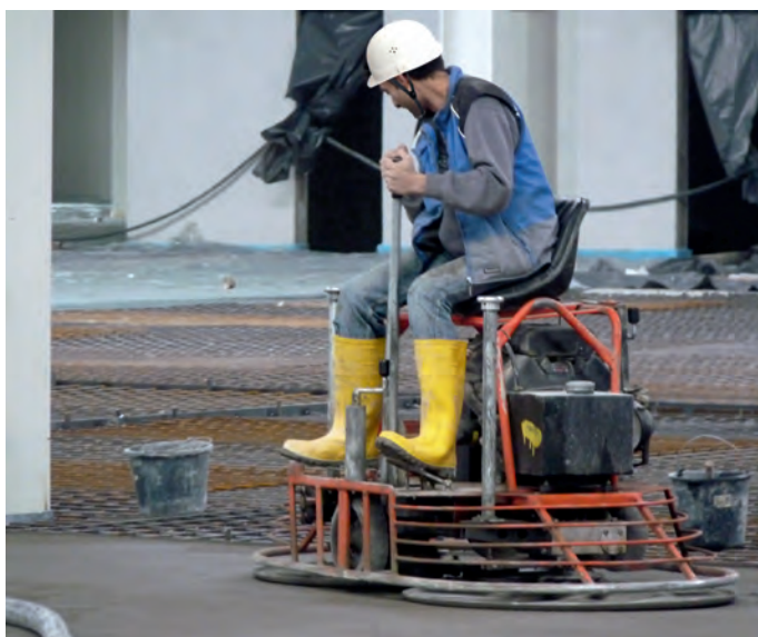
Abb. 1: Glättarbeiten in einer Halle
