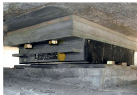
Längsbewegliches Führungslager für eine Auflast von bis zu 6 MN
