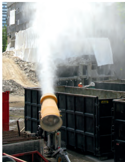
Abb. 2a und b: System zur Staubbindung – Beim Einsatz ist dafür zu sorgen, dass der Gefahrenbereich um dieses System gesperrt bzw. eindeutig gekennzeichnet ist
