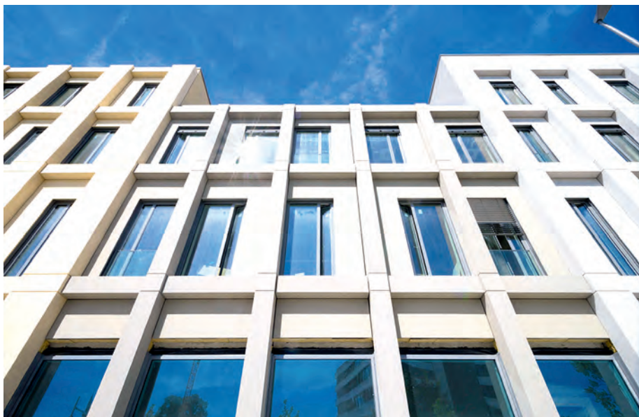
Abb. 4: Die gesamte Fassade des neuen Stadtquartiers in Neumarkt in der Oberpfalz nach der Fertigstellung (Foto: Solidian GmbH)
