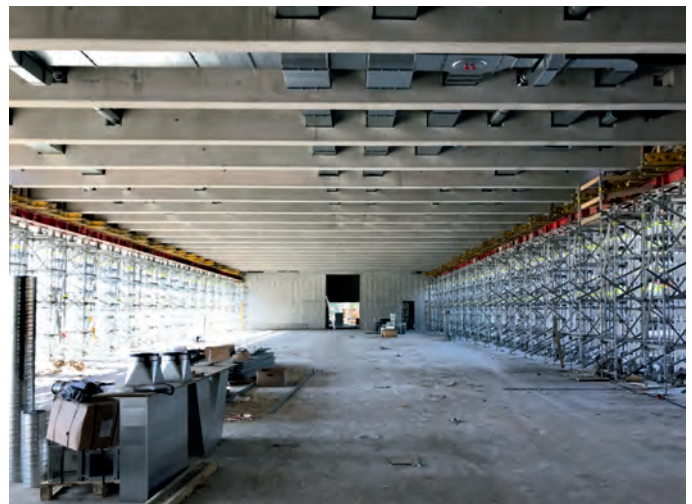
Abb. 7b und c: Temporäres Gerüst für den Bauzustand (Fotos: Rico Mattusch)
