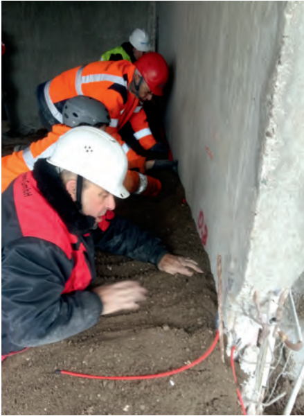
Abb. 2: Anlegen der Ladungen mit Sandverdümmung in den Obergeschossen
