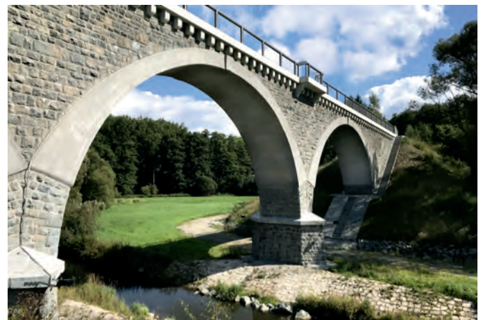
Abb. 8: Die sanierte Eisenbahnbogenbrücke in Naila (Foto: T. Strobel – NEMEPE)
