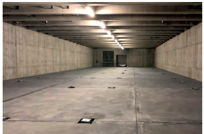
Abb. 9b: Fertiger Betonbau einschließlich Fußboden (Foto: Rico Mattusch)
