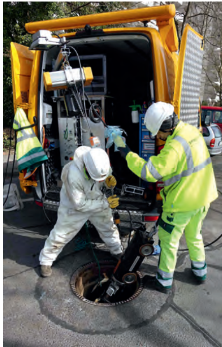
Die Schachtöffnung reicht: der eCutter und die PI.TRON Spachtel- und Verpress-Einheit konnten durch den Einstiegschacht in den Kanal abgelassen werden
