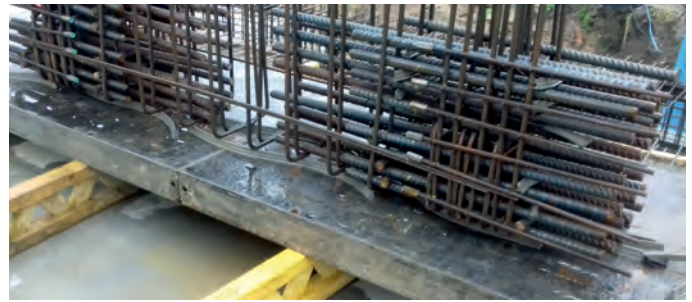
Abb. 6: Spezielle Bewehrung (Foto: Rico Mattusch)
