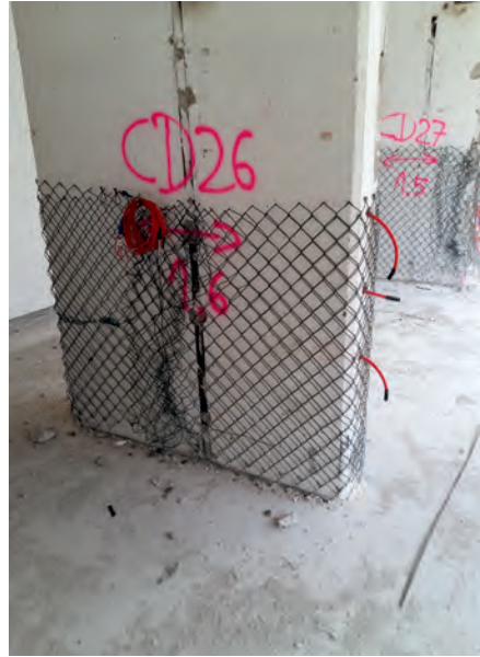
Abb. 3: Primärer Schutz gegen Sprengstreifflug mittels Maschendraht
