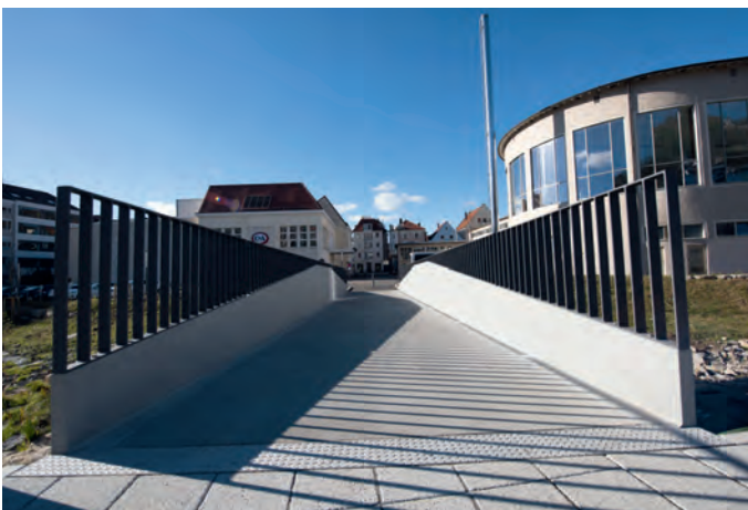
Abb. 7: Die neugebaute Brücke in Albstadt-Ebingen, erstmals ausschließlich mit Carbonbewehrung (Foto: Solidian GmbH)
