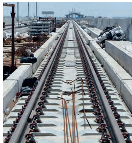
Fahrspuren mit einer Spurweite von 1 m
