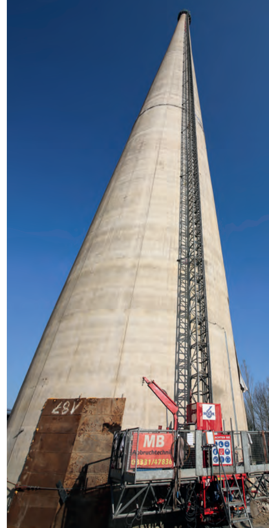
Abb. 1: Der Schornstein mit Höhenzugangstechnik und Montageplattform in der Höhe (Foto: Kai Mudra, Ostthüringer Zeitung)
