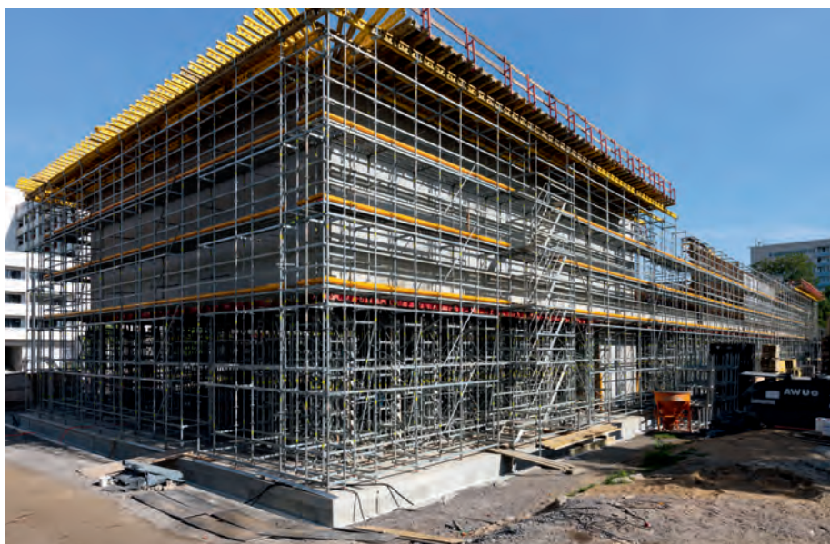
Abb. 4: Einrüstung des Rohbaus (Stiftung Bauhaus Dessau / Foto: Thomas Meyer / OSTKREUZ)
